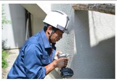
モルタル壁にあけた4つの穴に木工用ドリル刃4または5mmを付けたインパクトレンチで六角コーチボルト用の下穴をあけます。柱の表面から5cm程度の深さまで下穴をあけて下さい。
