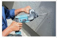
モルタルの壁は木工用ドリルで穴をあけられませんので、 基礎側下穴用4.5mmのコンクリート用ドリル刃を付けたハン マードリルで壁につけた4つのマーキングに壁の厚み分の穴 を開けます。
