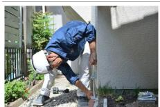
できるだけ基礎の高さの中央に受け金具が配置されるよう、 基礎側の金具の取り付け位置を決めます。
