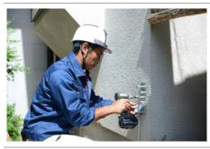
インパクトドライバーにソケット(21mm)を取り付けて六角コーチボルトを1本ずつ4本とも仮止めします。
