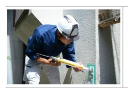
柱側の受け金具周りろコーチボルトの周囲をシール材でコーキングします。
