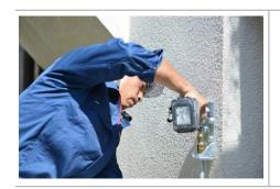
両ネジシャフトをワッシャーとナットで締め付けます。 片方をスパナ(24mm)かモンキーレンチで固定してから、ソ ケットビット(24mm深型)を付けたインパクトレンチでしっかりと 固定します。
