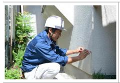
出隅にある通し柱は一般的に4寸(12cm×12cm)の柱が使わ れていますので、壁の厚みを差し引いて角から12cmは 壁の奥に柱があることになります。およその柱の位置を把握 して印をつけます。
