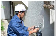
仮止めした4本のコーチボルトをしっかりと固定します。トルク をかけすぎて壁を破損しないように注意してください。
