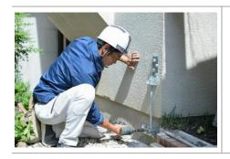
ピン付きアンカーにワッシャーを通し、アンカー用ボルトで基 礎側の受け金具をしっかりと固定します。
